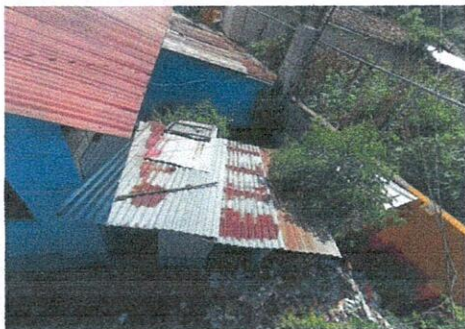
Foto 3 En la presente imagen nos muestra tambien lo difícil del acceso a agua potable hacia los servicios sanitarios por estar en la parte alta del área.
